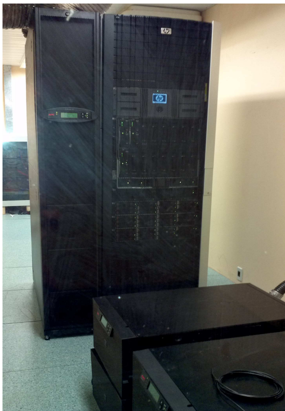
Ilustração 6: Servidor Blade com sistema de refrigeração dedicado
