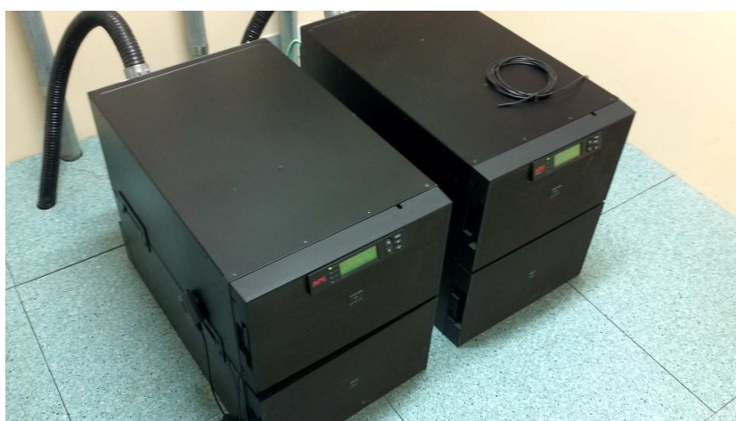
Ilustração 7: No-breaks de 20 Kva do HU
